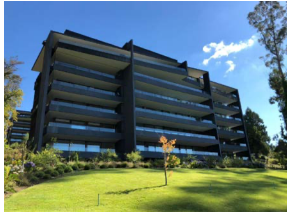
Edificio Rakün, Pucón, Chile Departamentos
